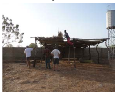
Mise en place du socco
