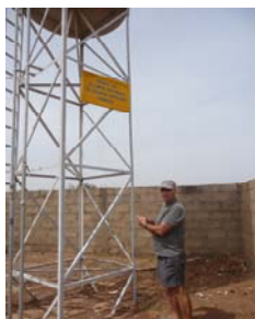
Le château d'eau du SPF
